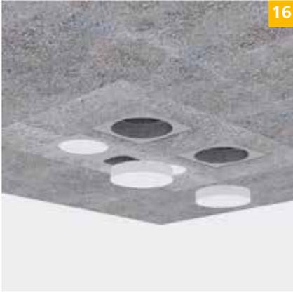
15. Öffnungen der Schächte sowie Verteiler müssen während der gesamten Rohbauphase verschlossen bleiben (Achtung: Gewährleistungsverlust bei Nichtbeachtung!). Zum Verschließen sind die mitgelieferten Verschlussstopfen zu verwenden.
