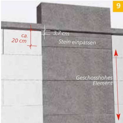
9. Nachdem die Filigrandeckenelemente verlegt wurden, kann der letzte Schachtstein des Geschosses eingepasst werden: Hierzu einen einzelnen Schachtstein auf der Steinsäge in der Art abgelängen, dass er im versetzten Zustand 3,7 cm unter der Decke endet.
